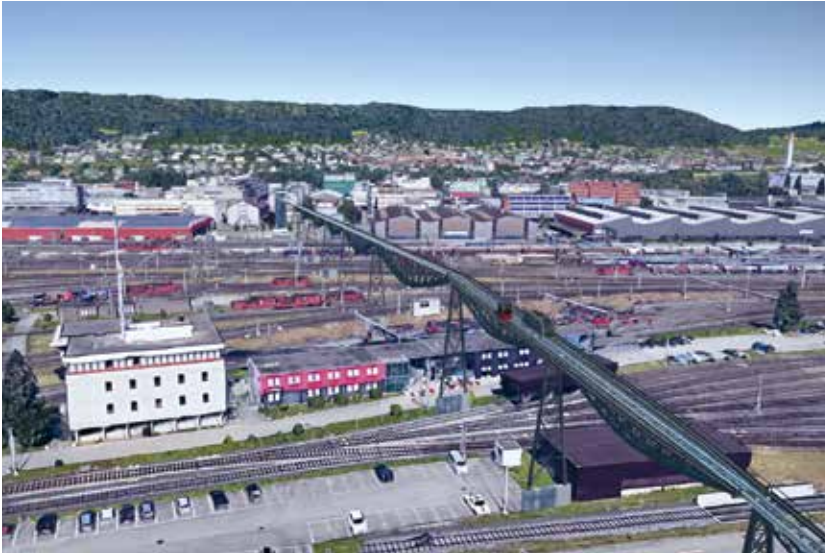
Virtuell Die Abbildung im digitalen 3D-Limmattstadtmodell ( limmatstadt-digital.ch ) zeigt zwei mögliche Fahrzeugtypen der Hochbahn.
